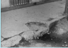
Banqueta con una coladera, 1945, Colección Casasola
