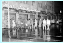
Desazolve de coladeras en una calle circa 1950, Colección Casasola
