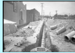
Tuberías en la calle Rebull, 1941, Museo Archivo de la Fotografía
